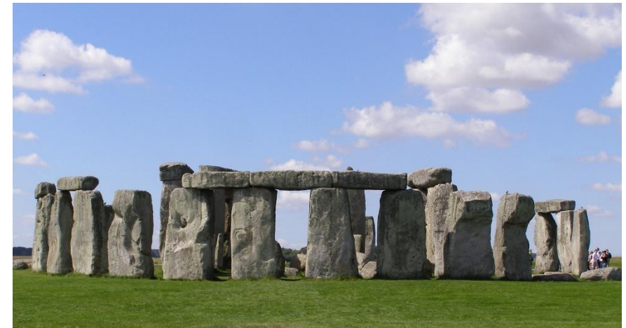
Ilustrasi mekanisme non-lentur pada batu di Stonehenge Inggris
